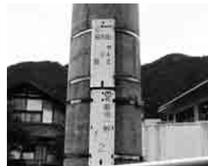
電柱表示の例
