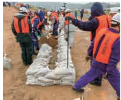
第2分団 “積み土のう工法”
