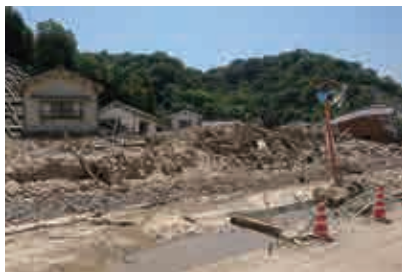
大量の土砂が流れ込んだ小屋浦地区
