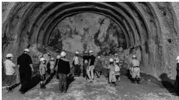
掘削中のトンネル内部を見学
