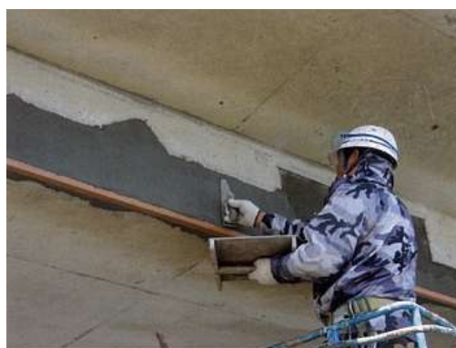
写真4-3 断面修復状況
