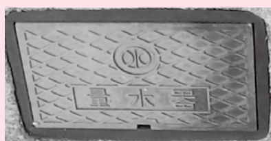
ボックス（画像は一例）を開けて確認。
