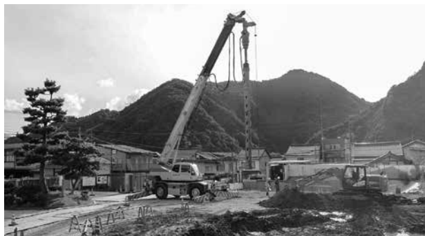
建設中のまちごとと魅力化センター(仮称)
