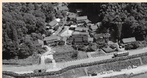
応急対策が完了した瀬尻・久料谷地区
