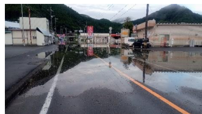
令和3年8月豪雨 因原地区内水状況
