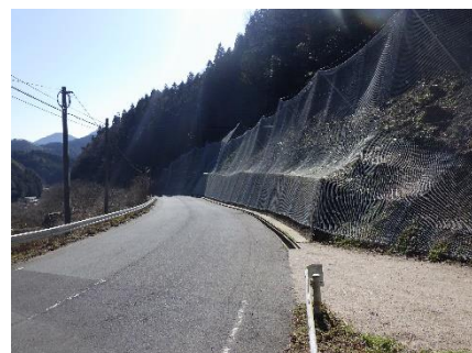
落石対策 町道三島三谷線
