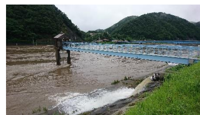
因原第2排水樋門での内水排除作業
