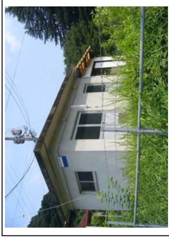
川本第1水源池
