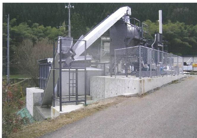
平成23年度に導入した湯谷温泉弥山荘のチップボイラー
