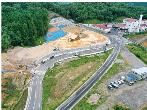
【施工中 令和2年7月撮影】
