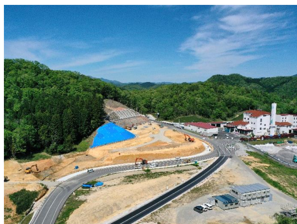
【施工中 令和2年5月撮影】
