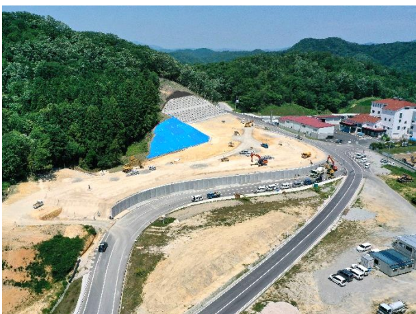
【施工中 令和2年6月撮影】
