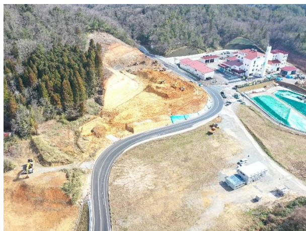
【施工中 令和2年3月撮影】
