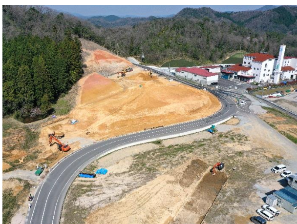
【施工中 令和2年4月撮影】
