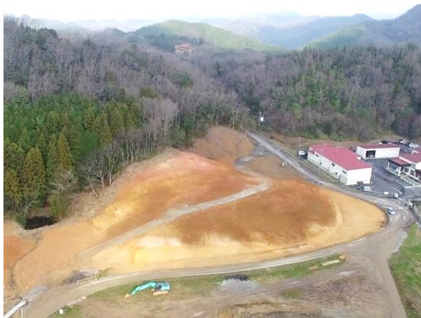
【着工前 平成30年12月撮影】
