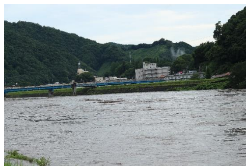
令和2年7月豪雨 川本堤防の様子
