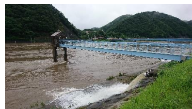
因原第2排水樋門 (内水排除作業状況)
