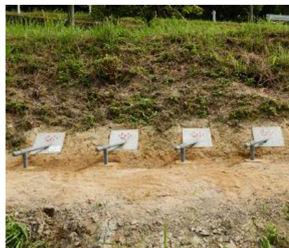
水抜きボーリング工 (田窪東工区)
