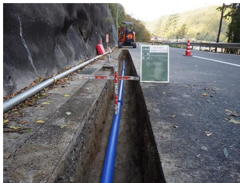
『水道管の布設替をした配水管』
