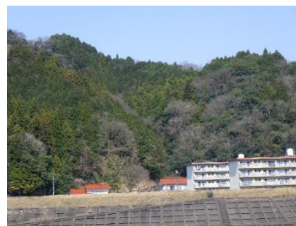
砂防堰堤工事（久座仁地区）
