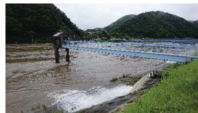
因原第2排水樋門 (内水排除作業状況)
