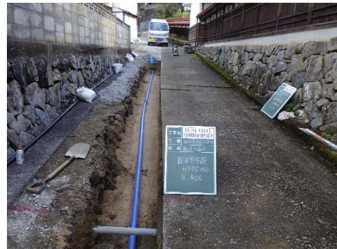
『水道管の布設替をした配水管』
