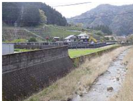
応急対策工事の様子（谷地区）
