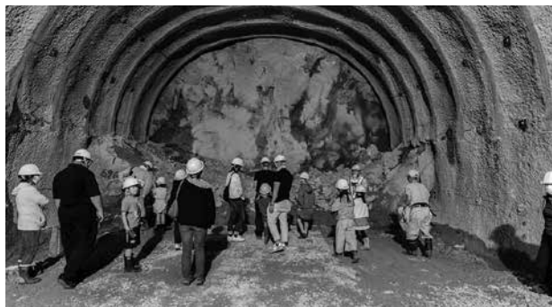
掘削中のトンネル内部を見学
