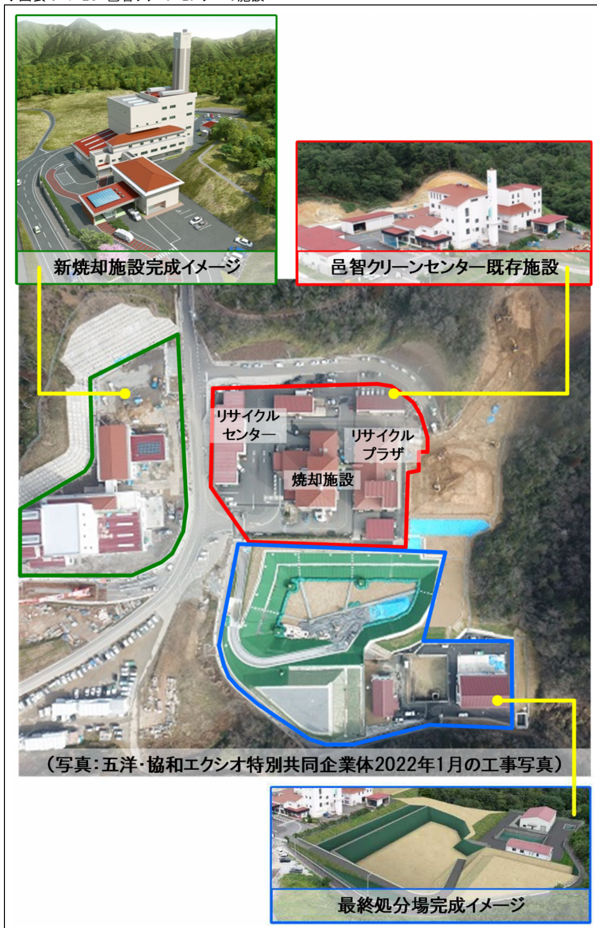
◆図表 3-1-28 邑智クリーンセンターの施設
