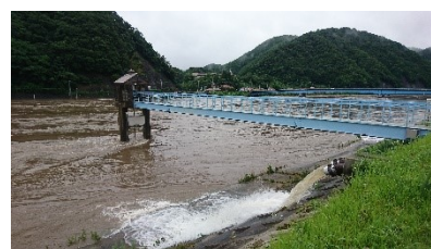
因原第2排水樋門での 内水排除作業
