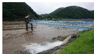
因原第2排水樋門での 内水排除作業
