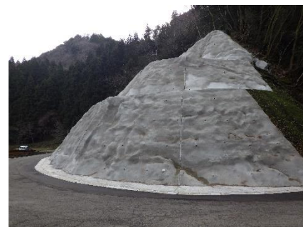
落石対策 町道柿木原線第2工区
