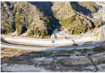
現在の瀬尻・久料谷地区の様子
