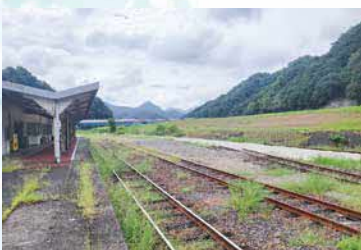
物件の撤去が完了した石見川本駅
